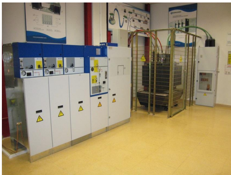
Figura 3: Vista de parte del Aula estado actual
